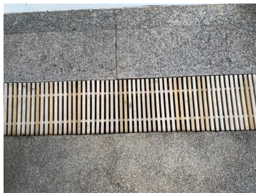
รูปที่ 3-20 ท่อระบายน้ำและตะแกรงดักขยะบริเวณท่อระบายน้ำภายในโครงการ
