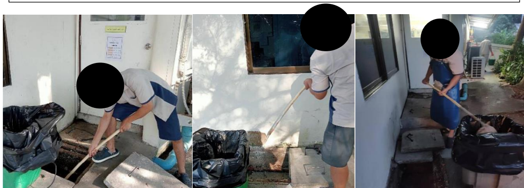
รูปที่ 3-6 เจ้าหน้าที่ทำความสะอาดบ่อดักไขมัน
