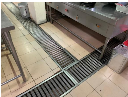
รูปที่ 3-20 ท่อระบายน้ำและตะแกรงดักขยะบริเวณท่อระบายน้ำภายในโครงการ
