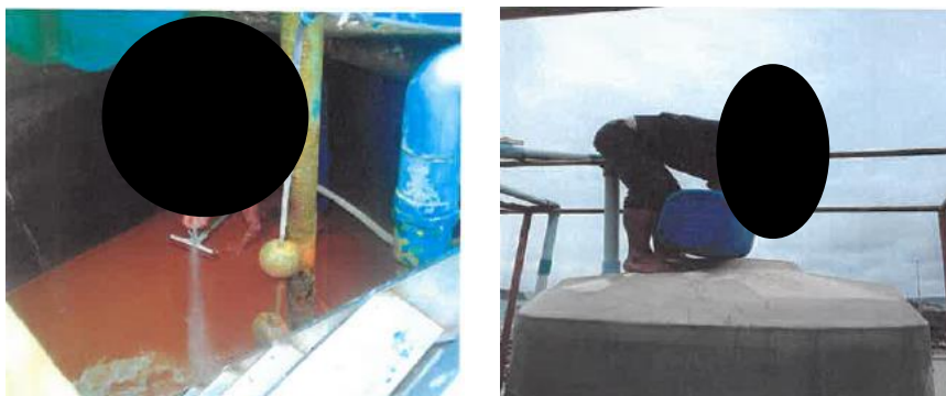
รูปที่ 3-3 การล้างทำความสะอาดถังน้ำใช้
